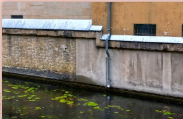
Schrägbleche an einem öffentlichen Gebäude in Berlin.
